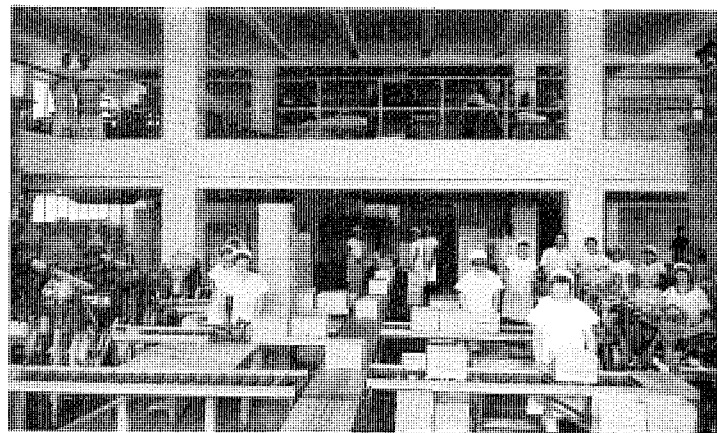
Detalj från K F:s margarinfabrik, Norrköping.
